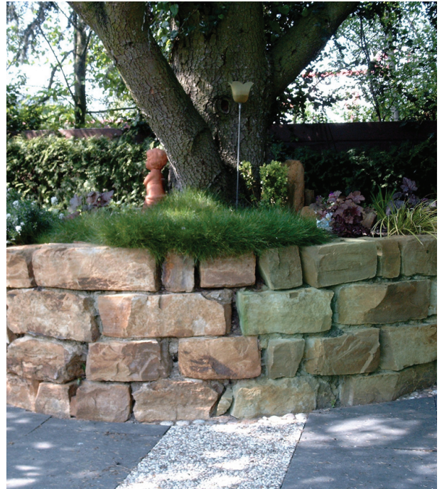
Natursteinbeet: Rechts vergrünt, links mit Lotuclean gereinigt und mit Porophob imprägniert.
