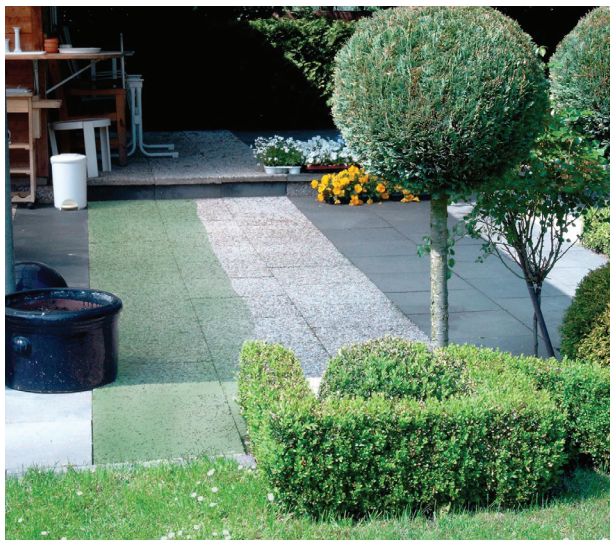
Waschbetonplatten in einem Garten, rechts 2 Jahre nach teilweiser Porophob-Behandlung, links ohne Porophob-Hydrophobierung vergrün.
